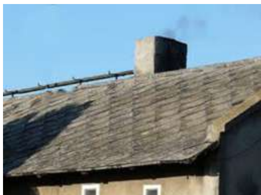
Rys. 4 Płyta azbestowo-cementowa karo
