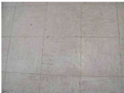
Rys. 8 Płyta podłogowa azbestowa
