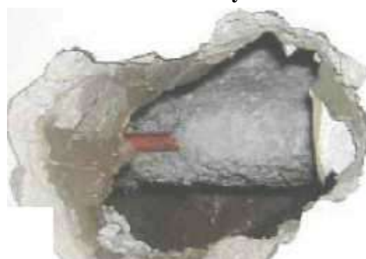
Rys. 7 Azbestowa izolacja rury
